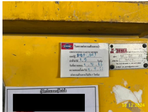
รูปที่ 2-37 สติกเกอร์ตรวจสอบตู้ไฟฟ้าในพื้นที่โครงการ
