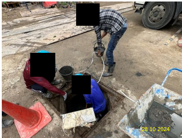
รูปที่ 2-25 การลอกวางระบายน้ำและบ่อดักตะกอน
